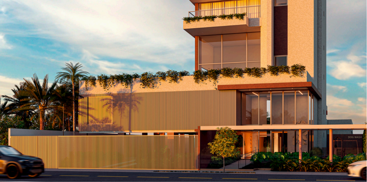
PÓRTICO DE ACESSO
