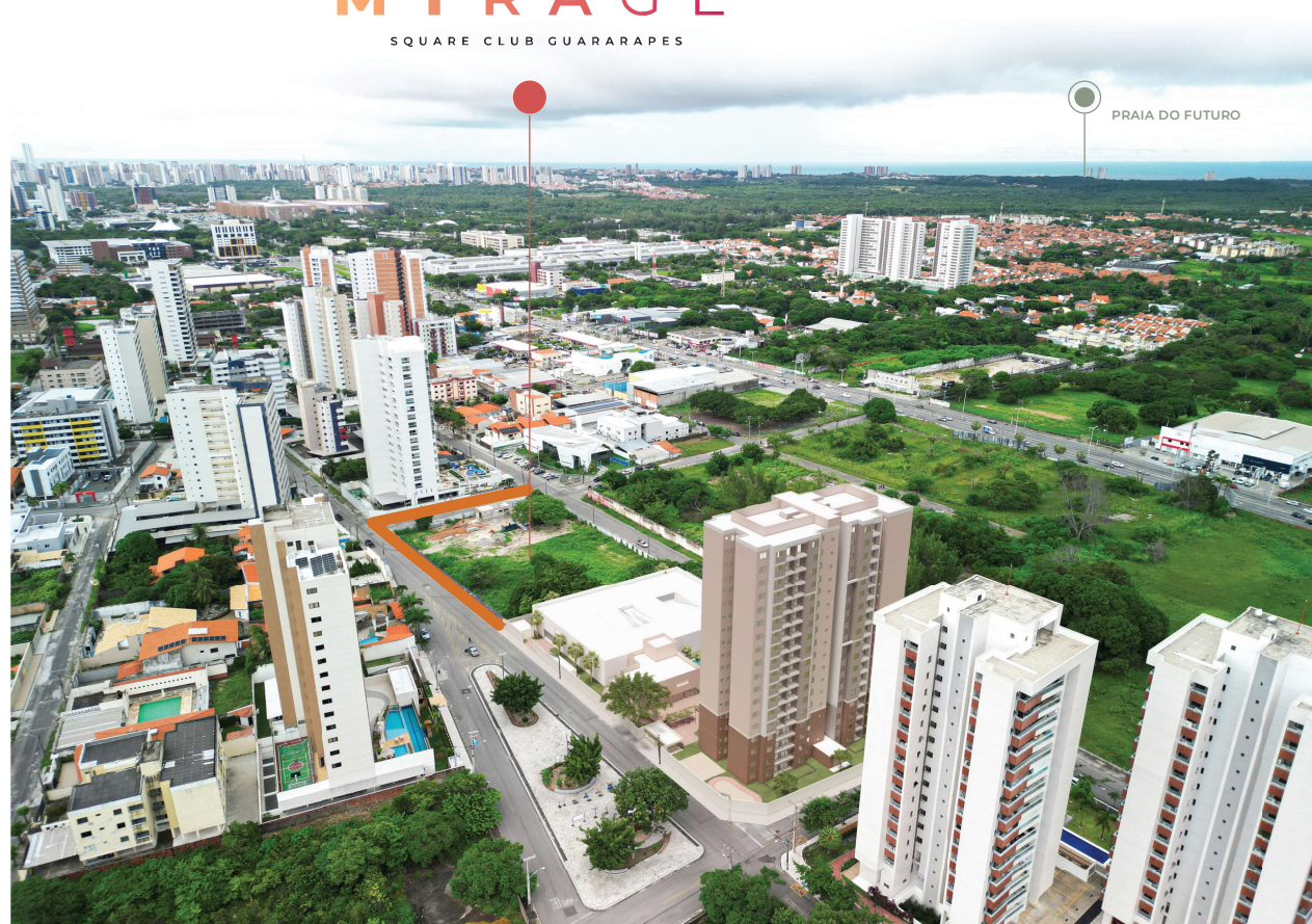
FOTO AÉREA DO TERRENO
