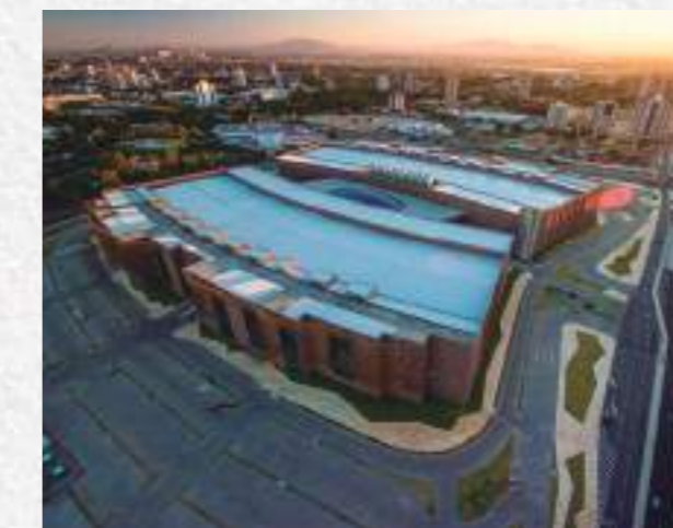
Centro de Eventos de Fortaleza
